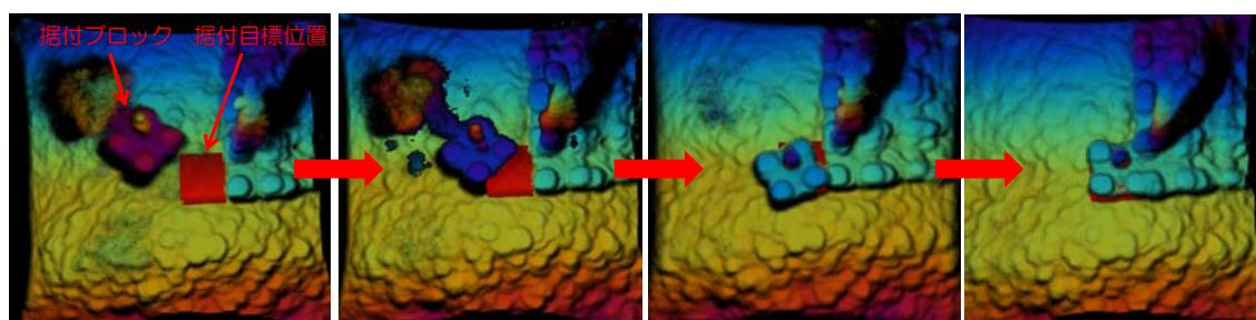
図3 被覆ブロック据付誘導状況（-25m）
